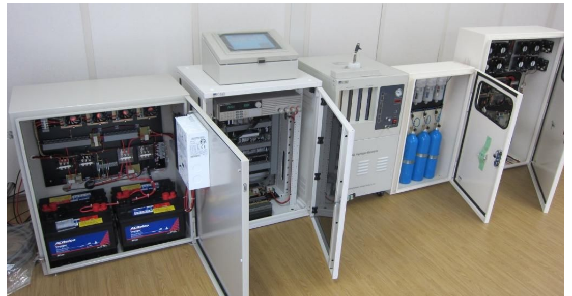
太陽光受電盤(蓄電盤) エネルギーモニター 水素発生装置 水素貯蔵装置 燃料電池
